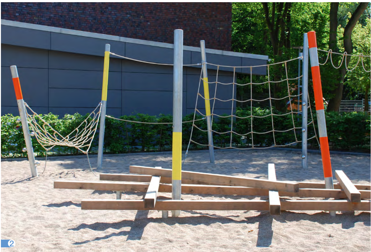
Wegespiel an teilweise farbigen Stahlpfosten mit Netzelementen zum Lümmeln und Beklettern, Wackelsteg, Balancierseil mit Handlaufseil und Zick-Zack-Balken zum Sitzen und Balancieren
