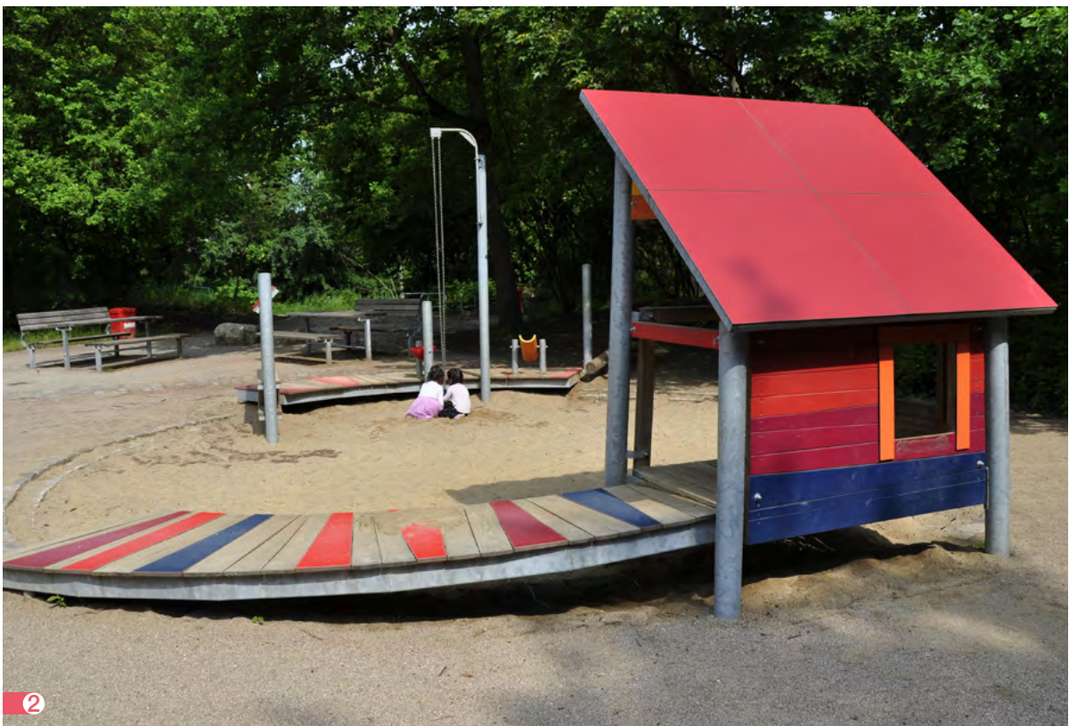
Spielbereiche für Kleinkinder mit niedrigen Plattformen aus Holz und farbigen Elementen aus HPL, teilweise überdacht, Dächer in Freiform oder als Pult- oder Satteldach
